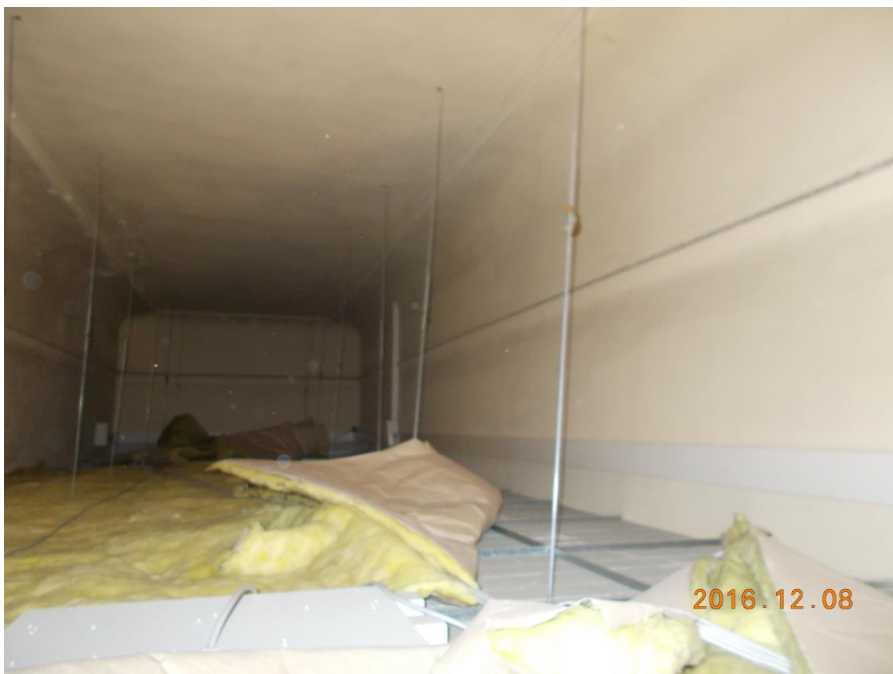
Immagine n. 11 – Immagini al di sopra del controsoffitto
