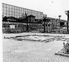
Il cantiere per la realizzazione della nuova fontana in piazza Comotto. Quella precedente richiedeva una manutenzione troppo costosa, perciò l'amministrazione comunale ha deciso di sostituirla con una "a raso"
