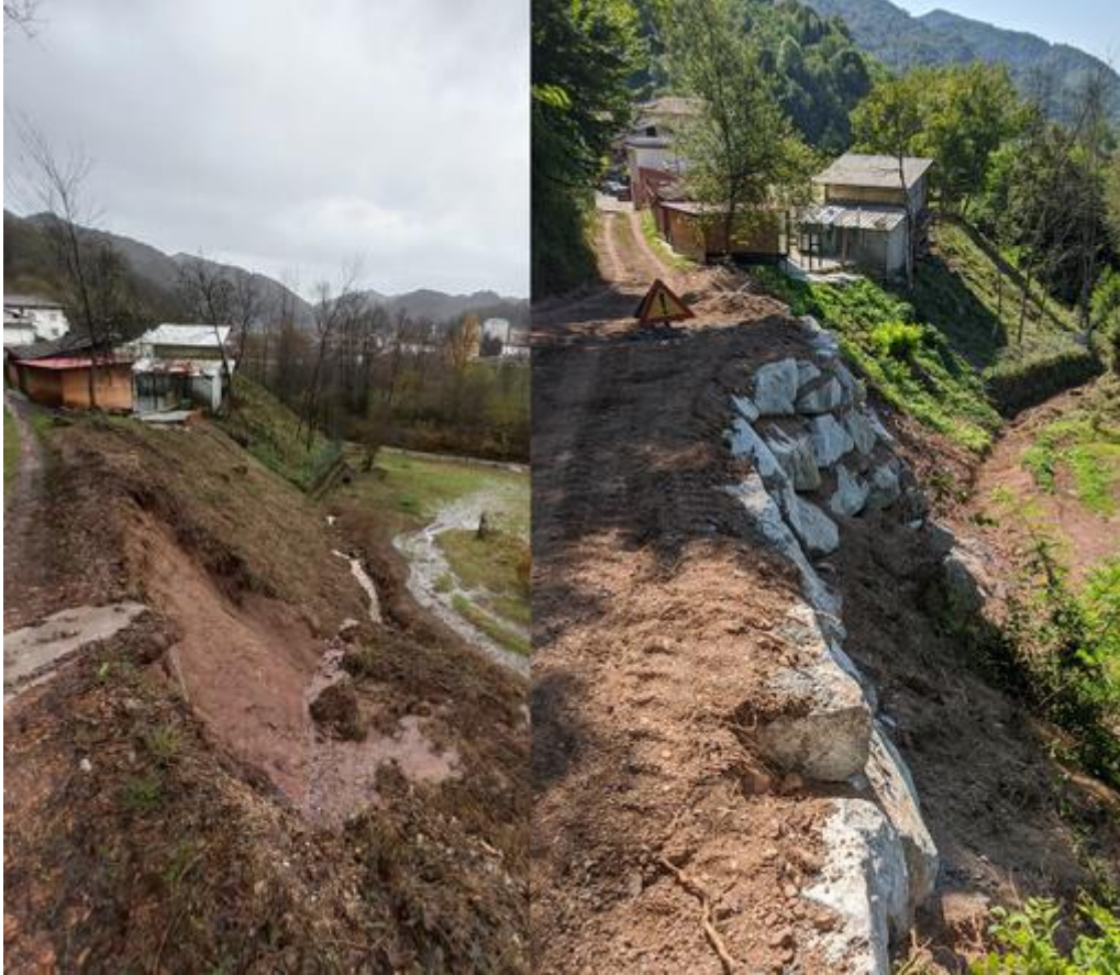
Prima e dopo i lavori
