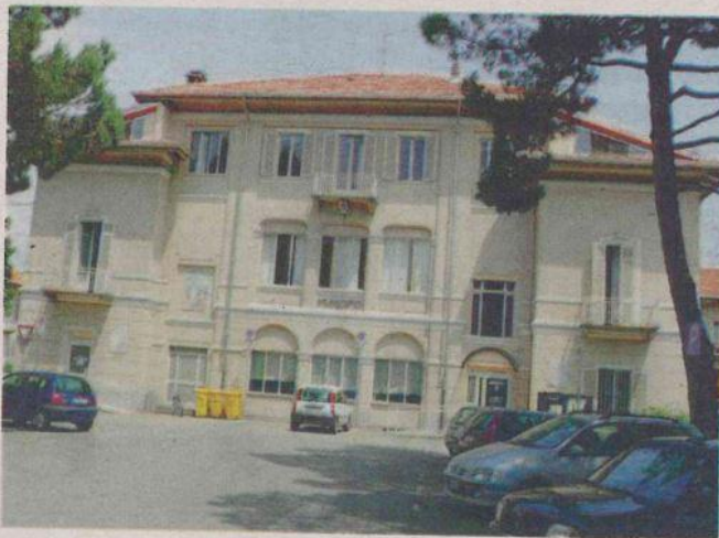
L'edificio che ospita il municipio di Vigliano Biellese
