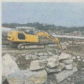
Lavori sul Chiebbia
