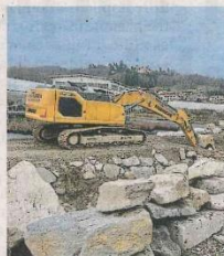
I lavori in corso sul Chiebbia
