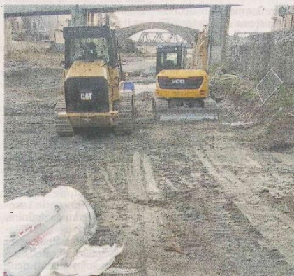
L'intervento di messa in sicurezza di un corso d'acqua
